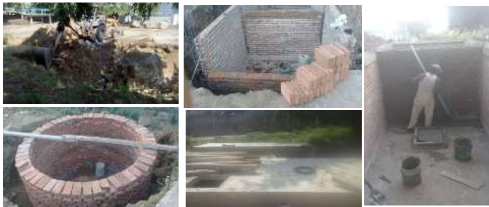
MANTENIMIENTO, ADECUACIÓN Y CONSERVACIÓN DE FOSA SÉPTICA Y POZO DE ABSORCIÓN DEL ÁREA DE LOS 500'S DE ESTE INSTITUTO. CON UN GASTO DE $150,000.00
