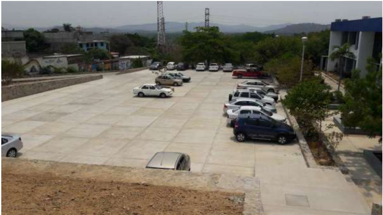
Obras asignadas a través de la redistribución de recursos PIFIT 2015: Estacionamientos de Arquitectura e Ingeniería en Sistemas Computacionales
