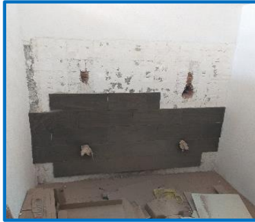
Durante la rehabilitación
