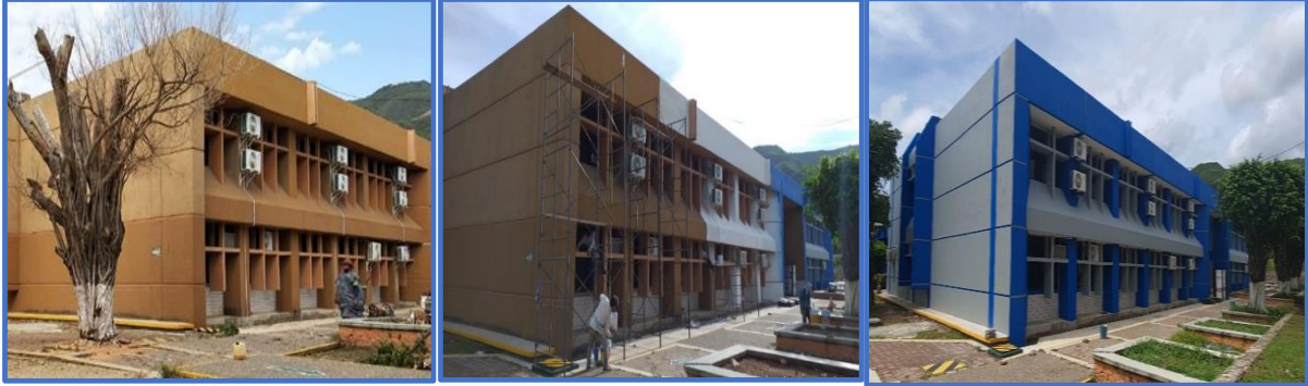
Antes de la rehabilitación
