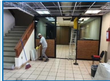
Durante la rehabilitación
