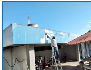
Durante la rehabilitación
