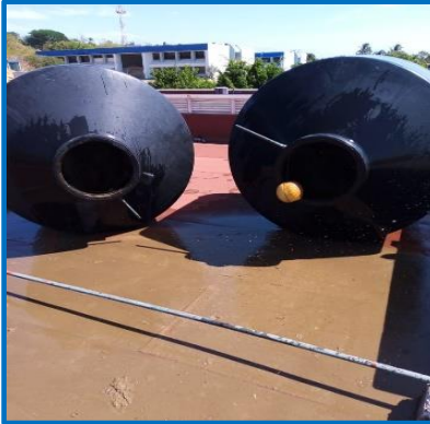
Durante la rehabilitación
