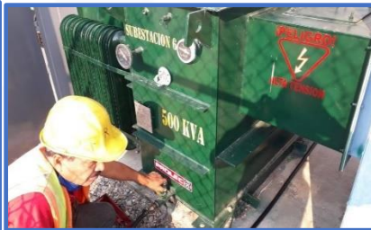
Durante la rehabilitación
