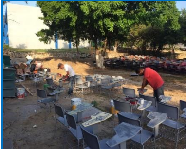
Antes de la rehabilitación
