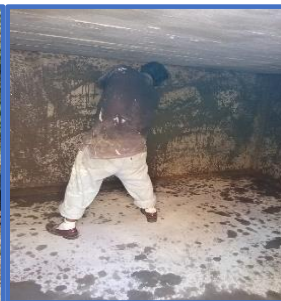
Durante la rehabilitación
