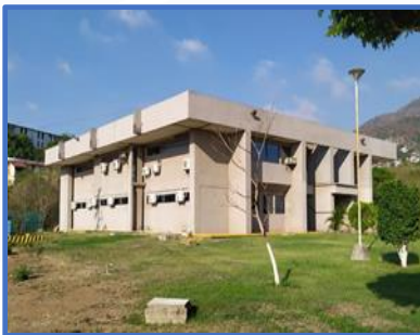
Antes de la rehabilitación
