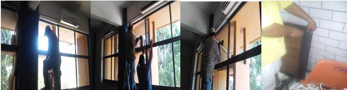
Mantenimiento de canceleria al interior del centro de cómputo
