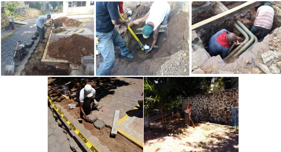
Mantenimiento correctivo a red hidráulica al interior del ITA
