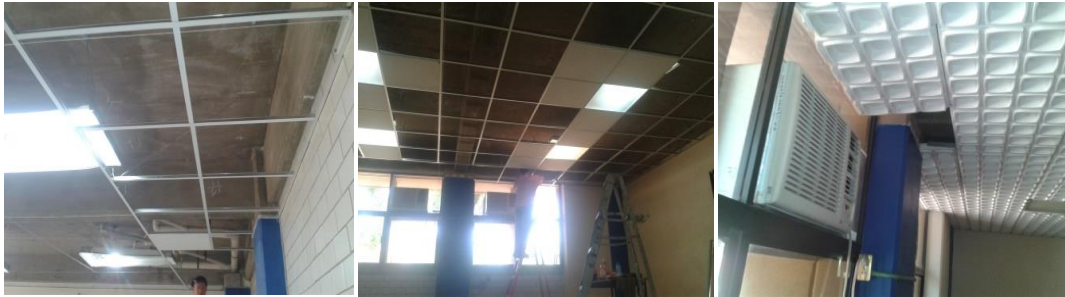
Mantenimiento de plafón falso en edificio de los 700's
