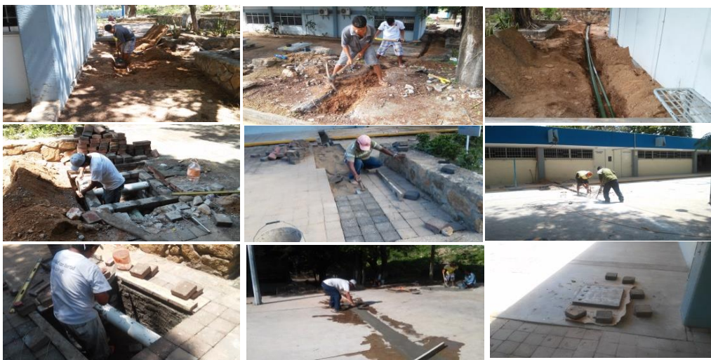
Mantenimiento de acometida de fibra óptica
