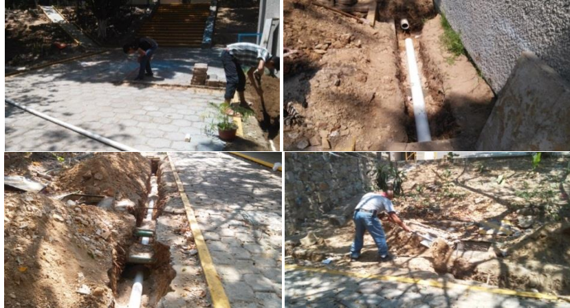
Mantenimiento y conservación de la red sanitaria al interior del ITA
