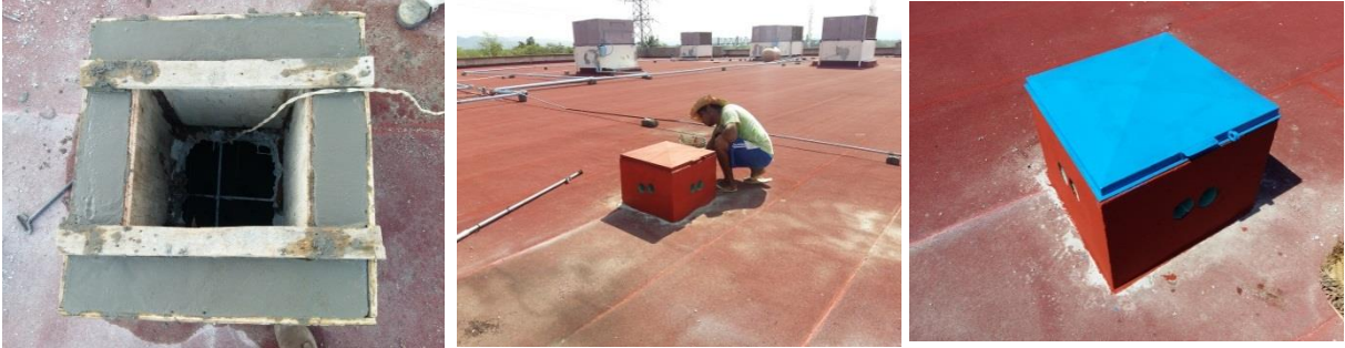
Mantenimiento de ducteria de aire acondicionado del Centro de Información
