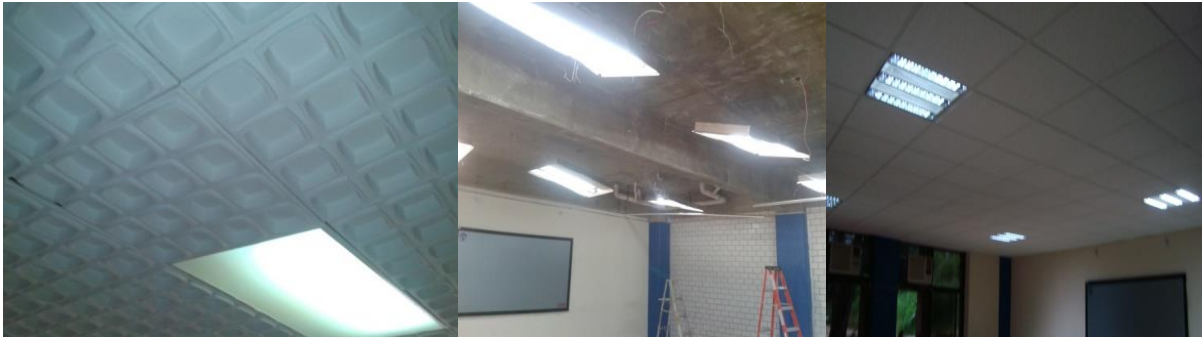
Mantenimiento y conservación de plafón del edificio de los 700's
