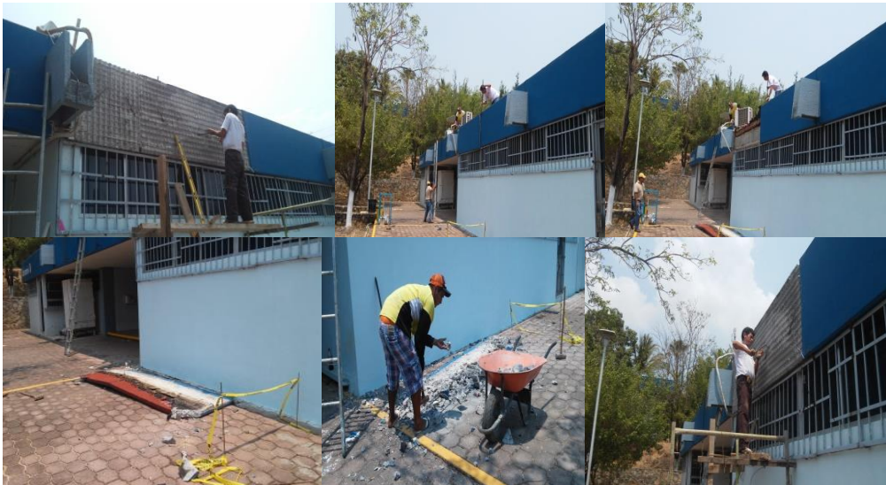
Mantenimiento de falso plafón en laboratorio de instrumental
