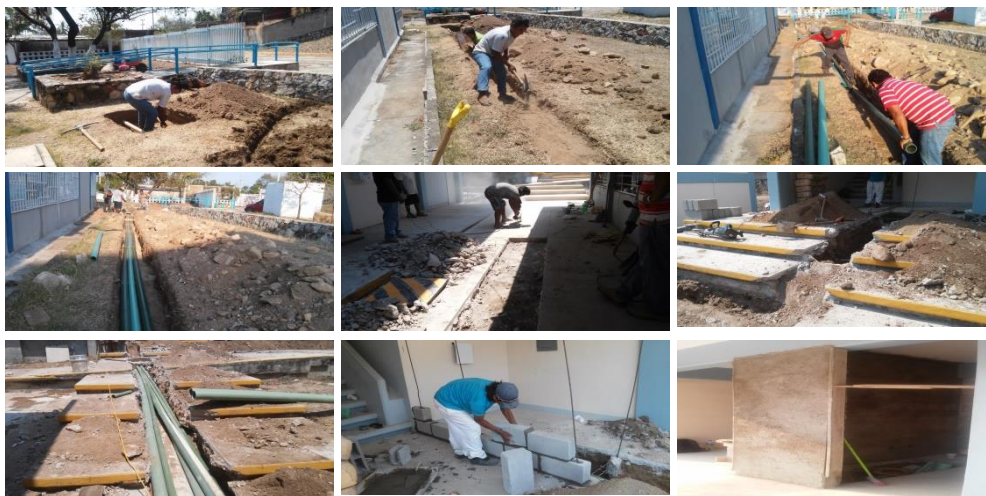
Obra civil: registro para la conectividad a internet en el ITA
