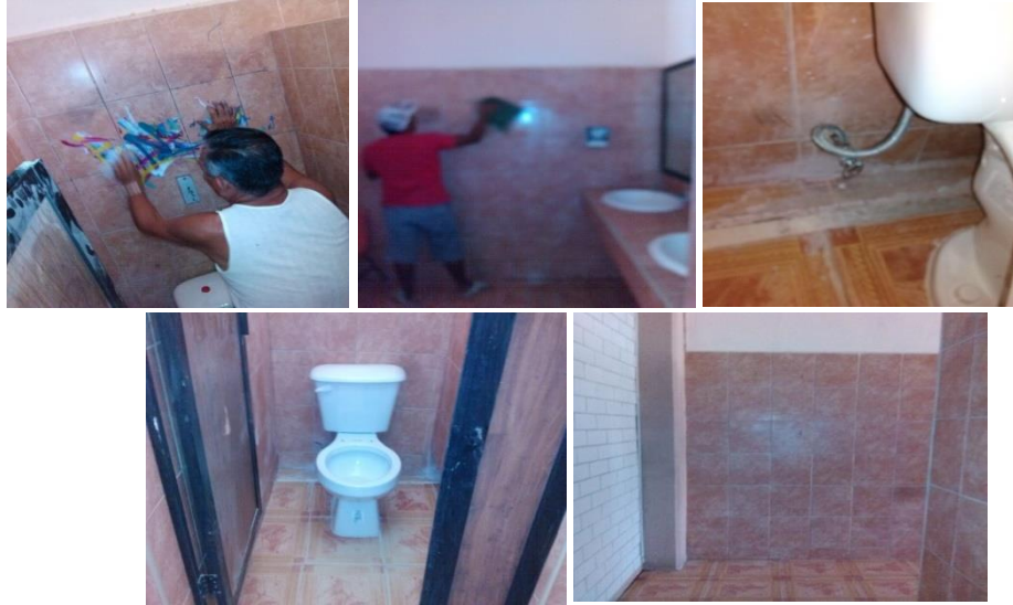
Mantenimiento correctivo a instalaciones sanitarias
